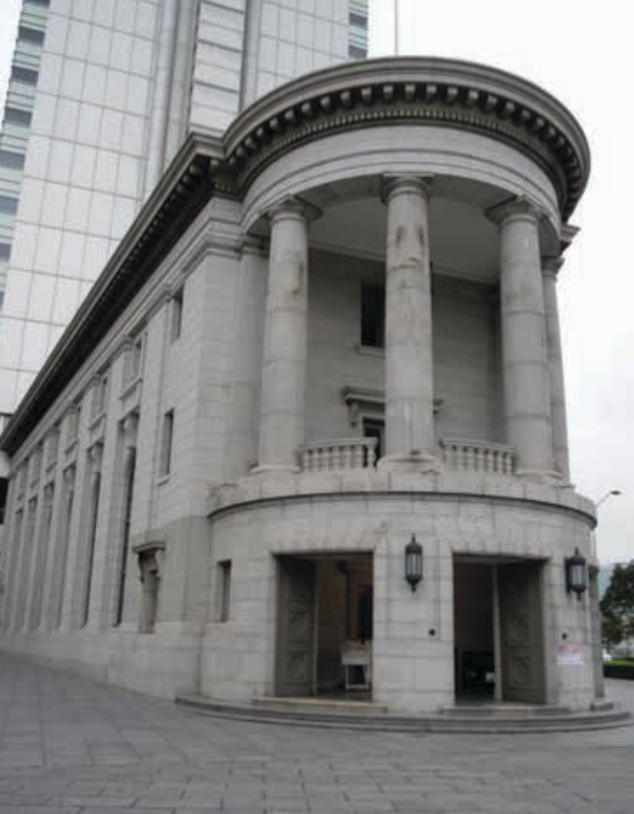
• Edificio del Yokohama Creative City Center, en Japón.
